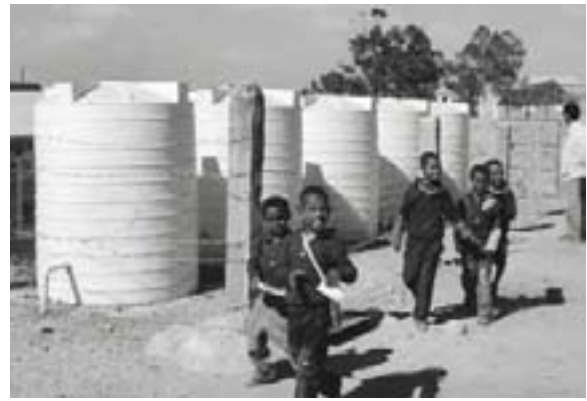
Das aus Nebel gewonnene Wasser wird in Tanks geleitet. Pro Tag können in der Nebelsaison mehrere hundert Liter gesammelt werden.
